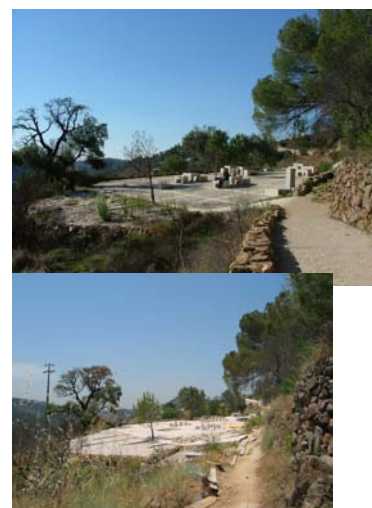
Fig. 12 – Plataforma de merendas concluída e em construção.
